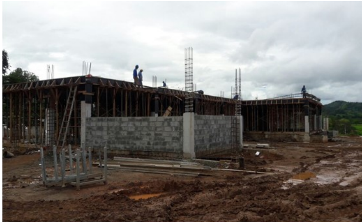
Foto N°1. Avances de la construcción de los nuevos edificios de la Extensión Universitaria de Soná
